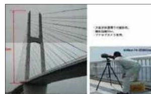
▲超望遠レンズによる高層 構造物の外観検査技術 (主塔外面)
