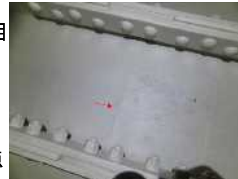
箱桁内部の溶接位置
