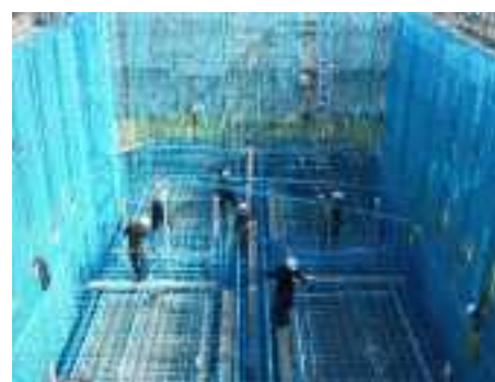
エポキシ樹脂塗装鉄筋の採用
