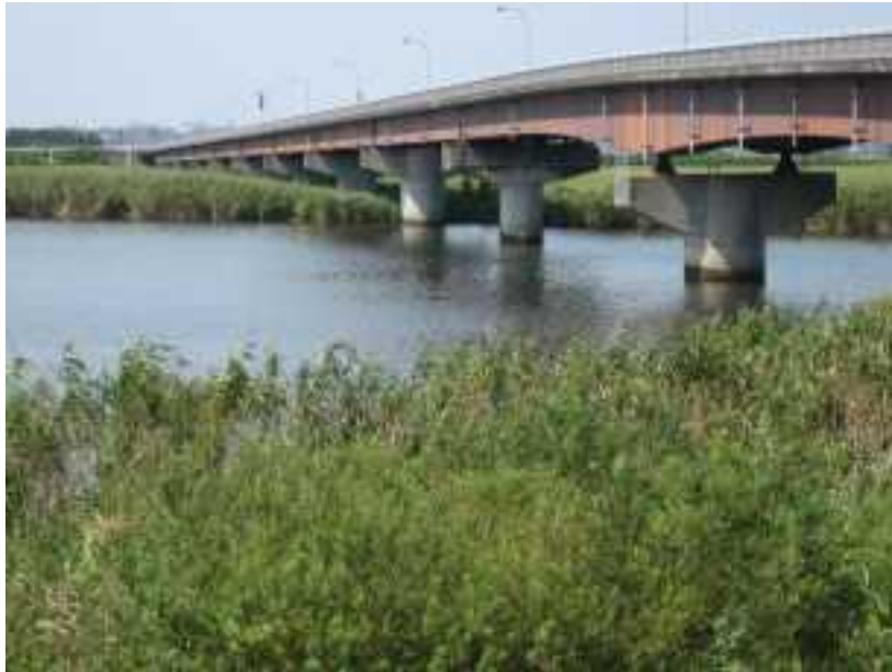
多径間連続の渡河橋
