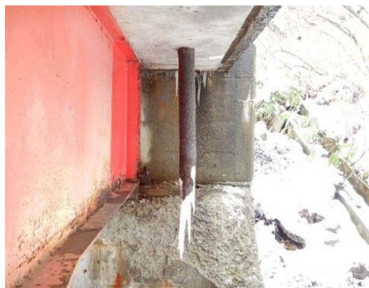
写真3-4 沓座部コンクリートの剥離
