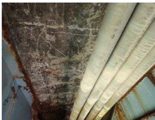
写真3-3 RC床版のひびわれ
