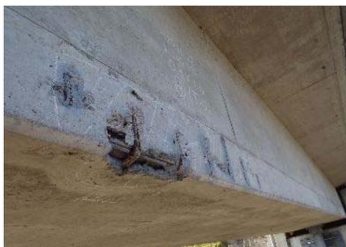
写真4-2 【損傷】主桁の剥離・鉄筋露出
