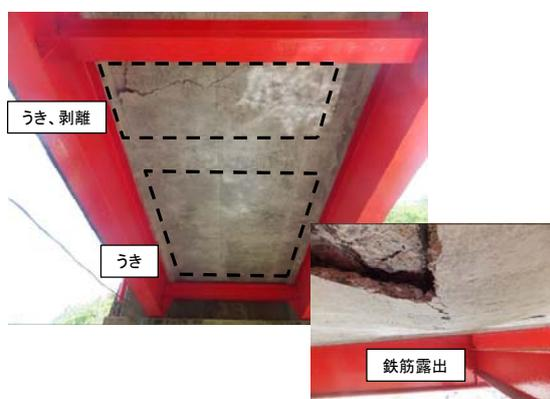
写真4-17 【損傷】
