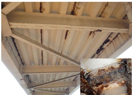
【損傷】床版の腐食
