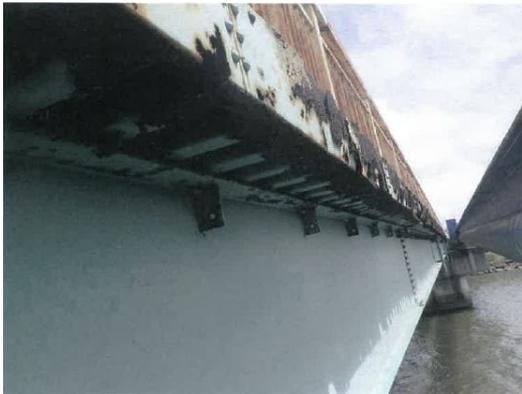
【損傷】床版の腐食
