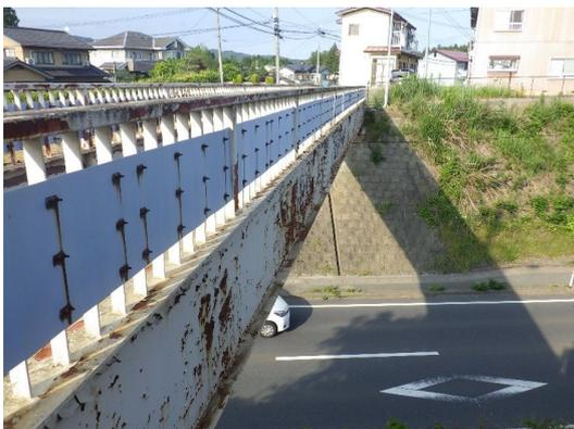
【損傷】主桁の腐食
