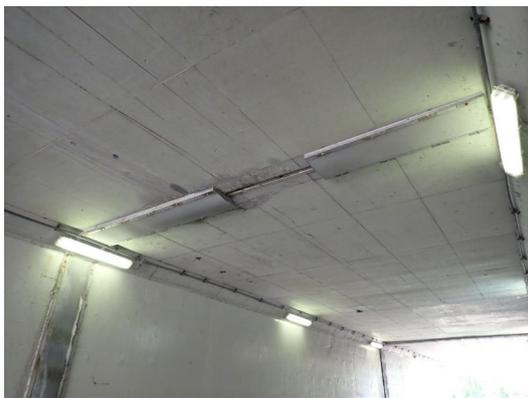
【損傷】頂版部の剥離、鉄筋露出
