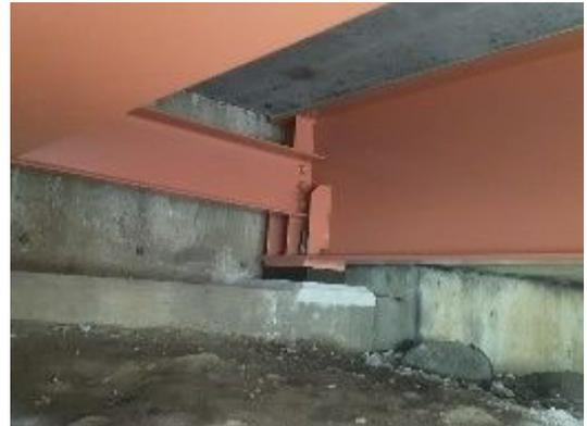
【損傷】主桁端部の腐食状況
