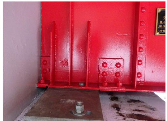
【損傷】主桁、支承の腐食
