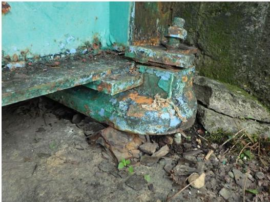
【損傷】支承の腐食
