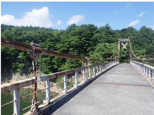
【損傷】吊材の腐食
