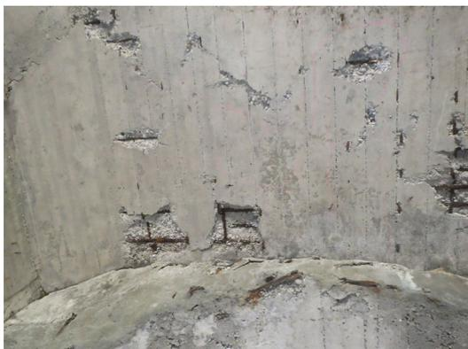
【損傷】頂版の剥離、鉄筋露出
