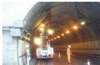
写真2-2 トンネル点検状況
