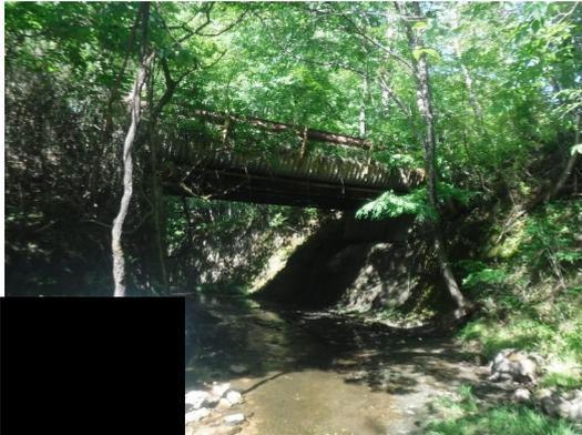
【損傷】主桁の腐食
