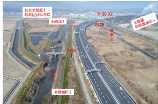
写真4-1 【全景】多賀城高架橋
