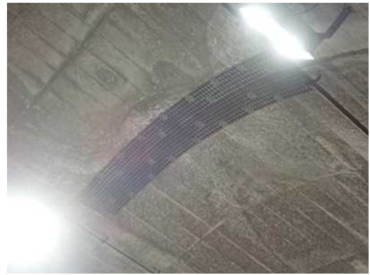
写真4-21 【対策】はく落防止対策工 （はく落防止用FRPメッシュ材）
