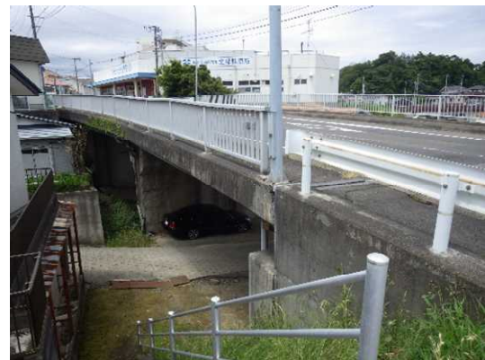
写真4-4 【全景】庚塚陸橋
