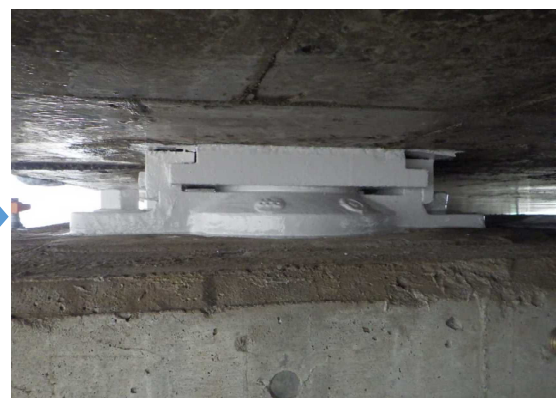
写真4-6 【対策】支承防錆
