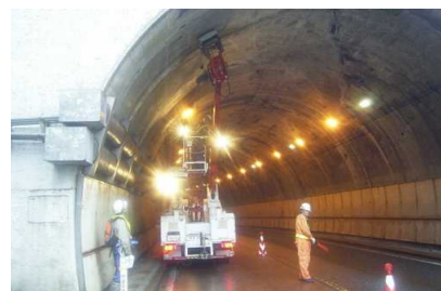
写真2-2 トンネル点検状況
