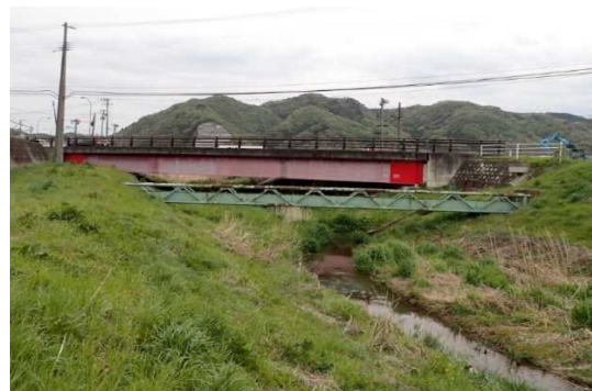
写真4-16 【全景】大太郎川橋
