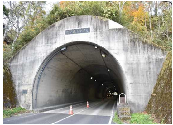
写真4-19 【全景】九の森トンネル
