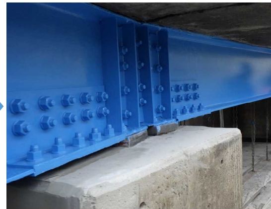
写真4-9 【対策】 主桁の当て板補修（塗替塗装）
