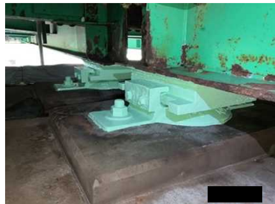
写真4-3 【対策】支承塗替塗装(R4.9補修)
