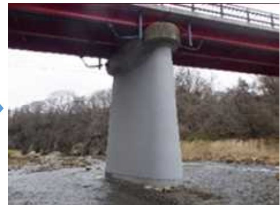
写真4-12 【対策】断面修復工 （橋脚補強 炭素繊維シート巻立）
