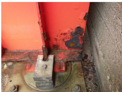
写真4-19 主桁端部の腐食事例
