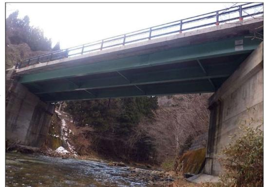
写真4-15 【対策】主桁再塗装
