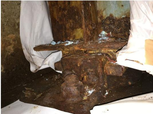
写真4-5 【損傷】支承の腐食
