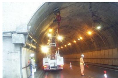
写真2-2 トンネル点検状況
