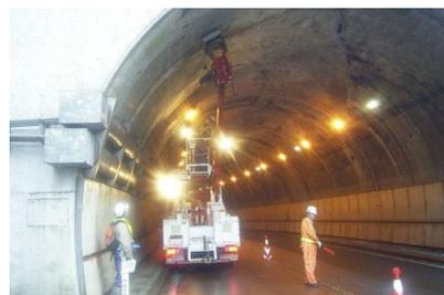
写真2-2 トンネル点検状況
