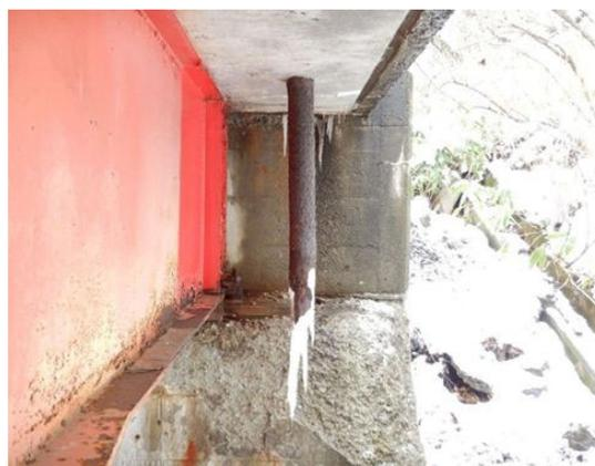
写真4-17 沓座部コンクリートの剥離
