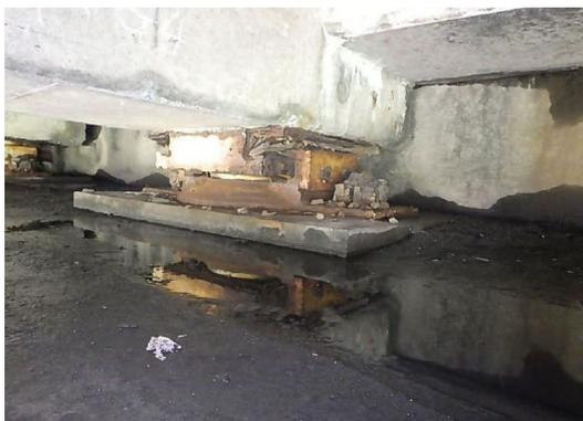
写真4-5 【損傷】支承の腐食
