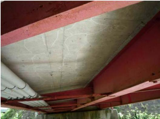
写真4-8 【損傷】床版ひびわれ
