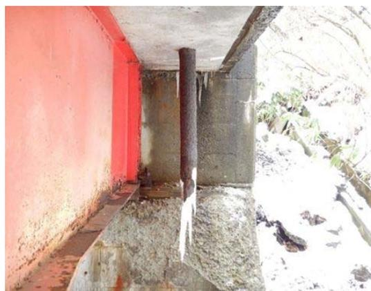
写真4-20 沓座部コンクリートの剥離
