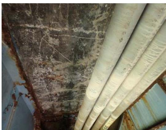
写真4-19 RC床版のひびわれ
