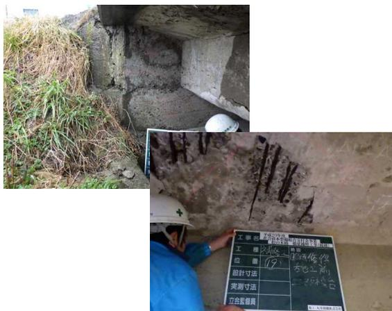
写真4-11 【損傷】鉄筋露出状況
