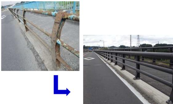
写真4-8 【損傷】防護柵の破断
