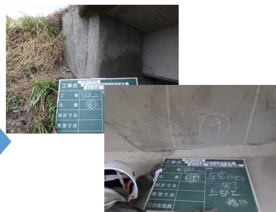
写真4-12 【対策】断面修復による補修
