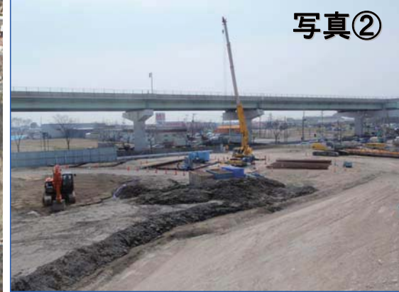
▲橋梁下部工(基礎)工事中
