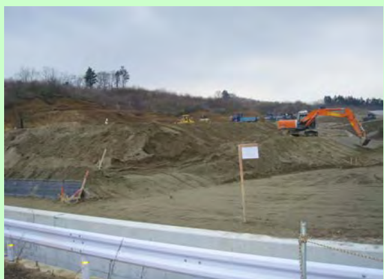
▲ 盛土工事の様子
