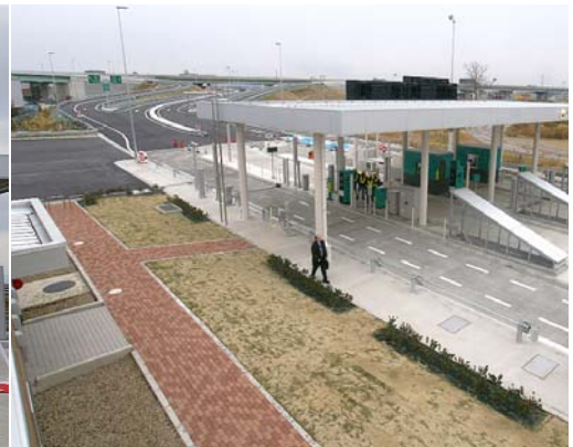
▲仙台港ICの状況
