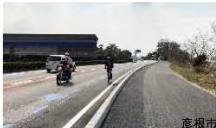
路肩拡幅の整備例
