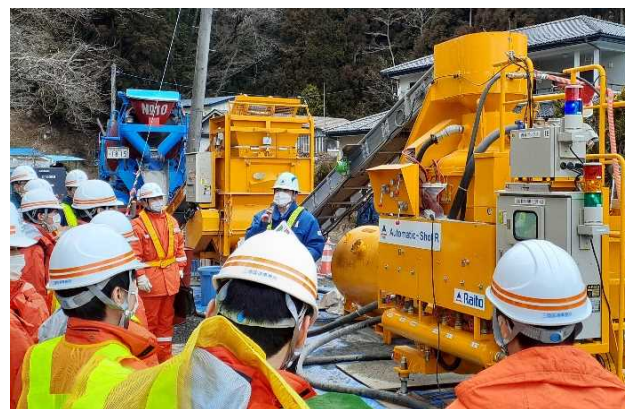
▲全自動でモルタルを吹付するシステムの説明
