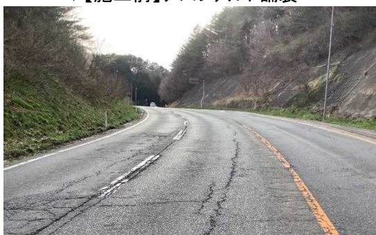
▼【施工前】アスファルト舗装
