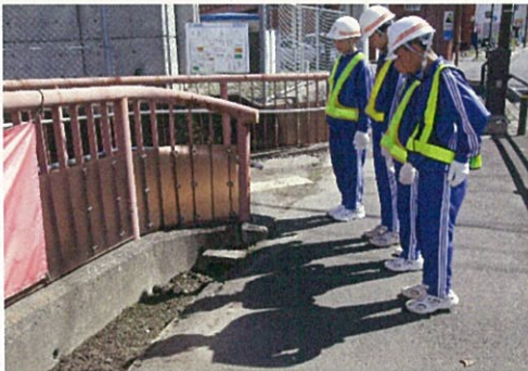
市役所前歩道橋の点検
