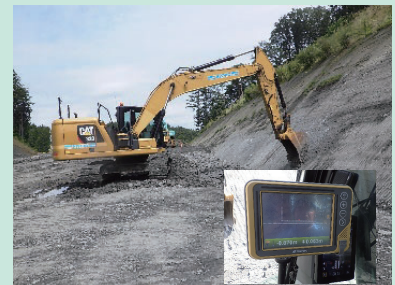
ICT建設機械による施工
