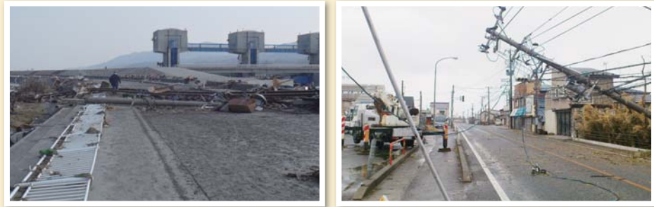
▲【東日本大震災】岩手県宮古市(国道45号)
