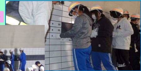
タイル張り作業
