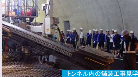
トンネル内の舗装工事見学
