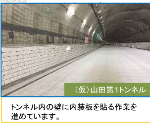
トンネル内の壁に内装板を貼る作業を進めています。
