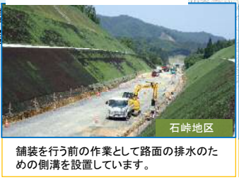
舗装を行う前の作業として路面の排水のための側溝を設置しています。
