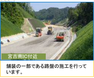
舗装の一部である路盤の施工を行っています。
