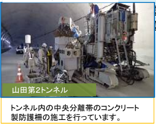
トンネル内の中央分離帯のコンクリート製防護柵の施工を行っています。
