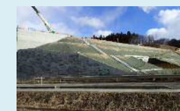
◆完成盛土状況
