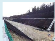
◆完成切土状況
