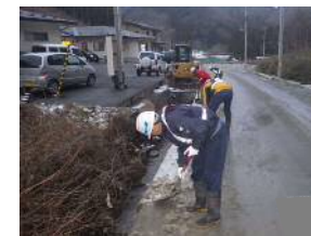
◆林道山谷線 山田町大沢地区
