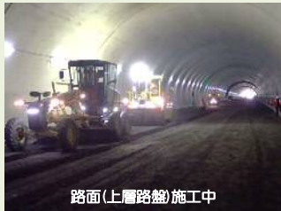
路面(上層路盤)施工中
