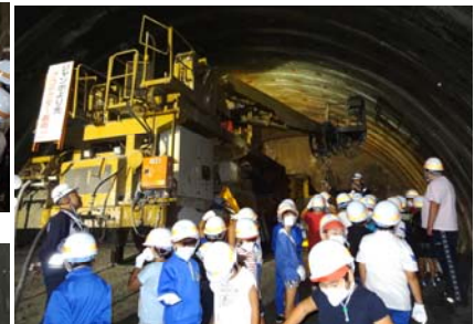
◆トンネル掘削機械の大きさにびっくり!
