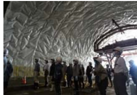
▲坑口部防水シート張施工説明状況
