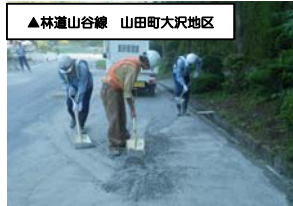
▲林道山谷線 山田町大沢地区
