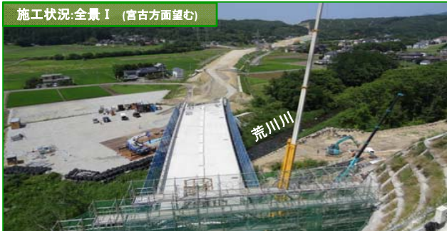
施工状況:全景 I (宮古方面望む)
