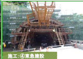
施工:④東急建設
