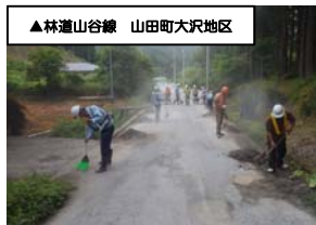
▲林道山谷線 山田町大沢地区
