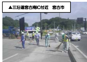
▲三治道宮古南IC付近 宮古市
