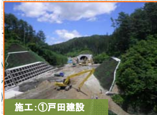
施工:①戸田建設
