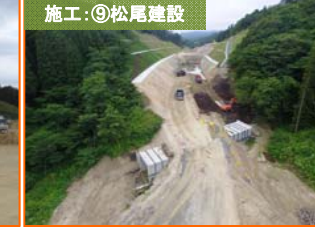
施工:⑨松尾建設
