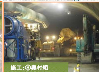
施工:⑧奥村組
