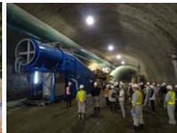
▲トンネル内大型施設見学状況!
