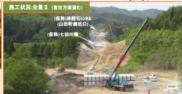
施工状況:全景 II (宮古方面望む)
