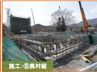
施工⑧奥村組
