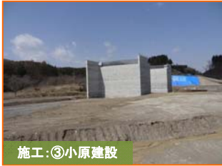
施工③小原建設
