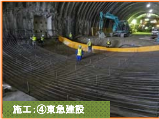
施工④東急建設
