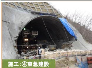
施工:④東急建設
