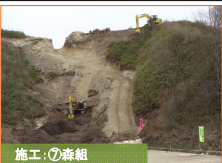
施工:⑦森組
