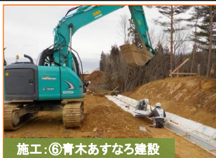
施工:⑥青木あすなろ建設
