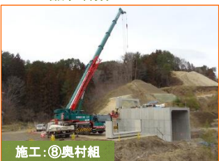
施工:⑧奥村組
