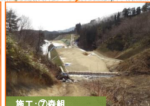
施工：⑦森組
