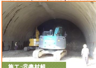
施工：⑧奥村組
