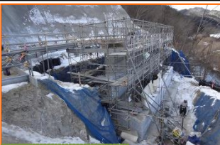
施工：④東急建設
