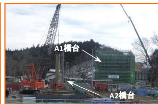
施工：⑧奥村組
