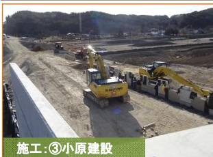
施工:③小原建設
