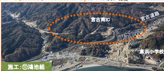
施工:⑪鴻池組
