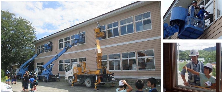
▲3台の高所作業車を使用して窓拭きを行いました。
