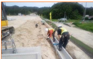
施工：③小原建設
