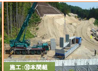
施工:⑩本間組
