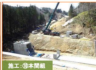
施工:⑩本間組
