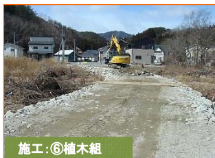
施工:⑥植木組
