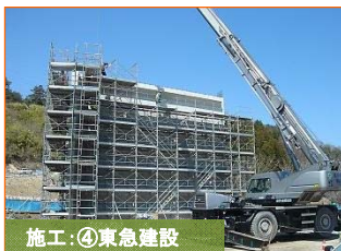
施工:④東急建設
