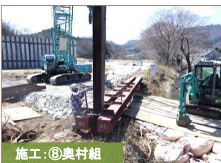
施工:⑧奥村組
