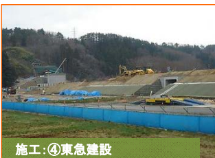
施工:④東急建設
