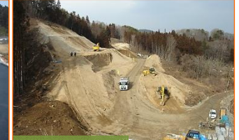
施工:⑩本間組
