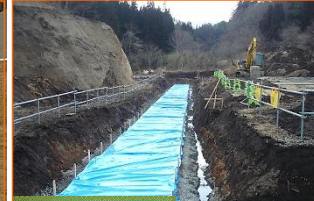
施工:⑥植木組
