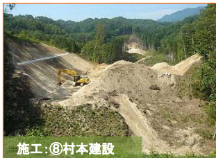
施工: ⑧村本建設
