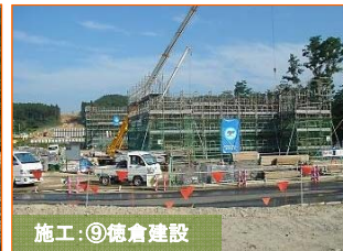
施工: ⑨徳倉建設
