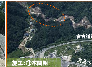
施工: ⑪本間組
