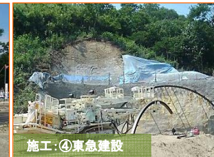
施工: ④東急建設
