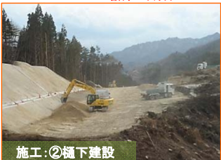
施工:②樋下建設
