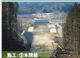
施工:⑨本間組
