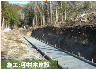
施工:④村本建設
