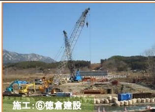
施工:⑥徳倉建設
