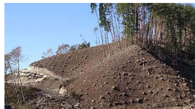
▲伐採完了(山田町間木戸地区)
