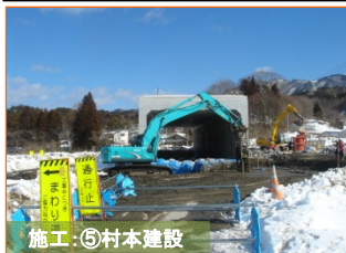
施工:⑤村本建設
