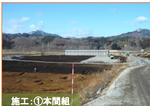
施工①: 本間組
