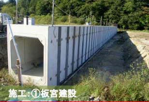
施工:①板宮建設
