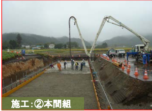
施工:②本間組
