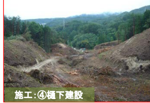
施工:④樋下建設
