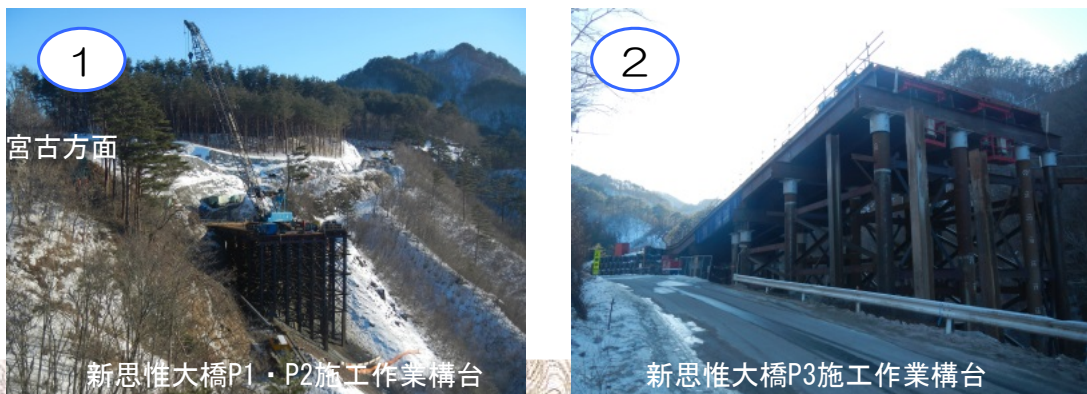
① 浜岩泉地区構造物工事 施工:大豊建設(株)
