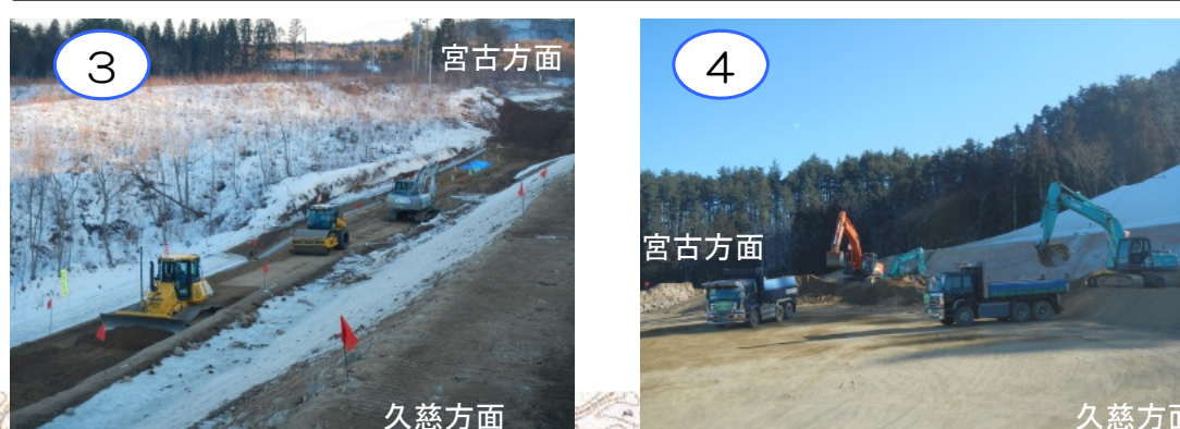
③ 菅窪地区道路改良工事 施工:村本建設(株)
