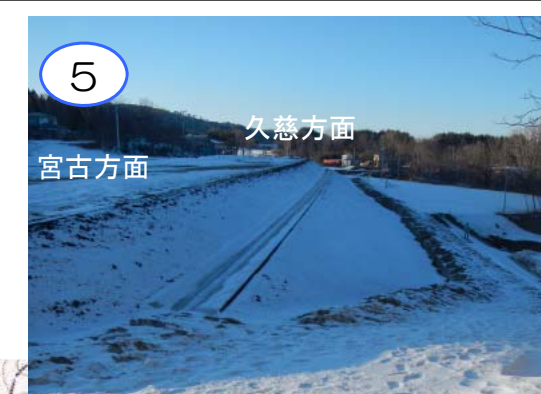
芦渡南地区道路改良工事 施工:(株)吉田組
