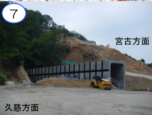
⑥ 柏木平北地区道路改良工事 施工:村本建設(株)
