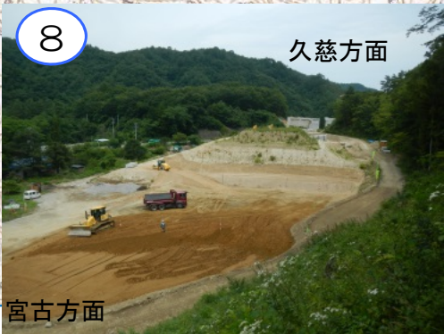
⑤ 柏木平南地区道路改良工事 施工:昭栄建設(株)
