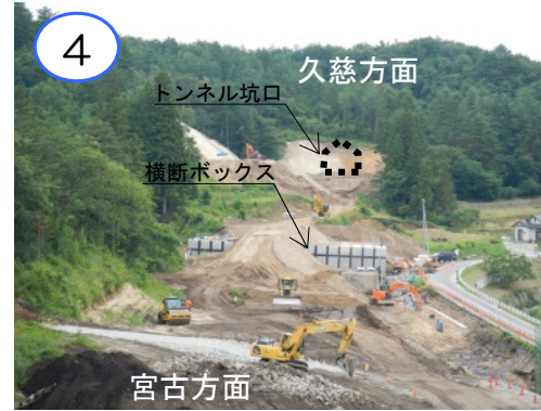
② 国道45号 萩牛地区道路工事 施工:佐藤工業(株)
