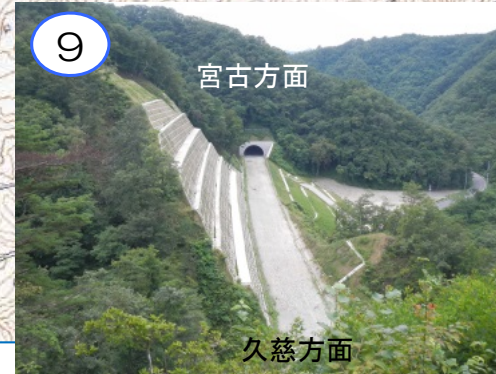
柏木平第1トンネル久慈側坑口~ 柏木平第2トンネル宮古側坑口
