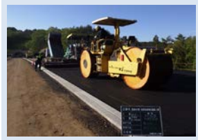
アスファルト舗装 施工状況
