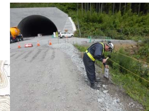
標識の位置出し等を進めています。
