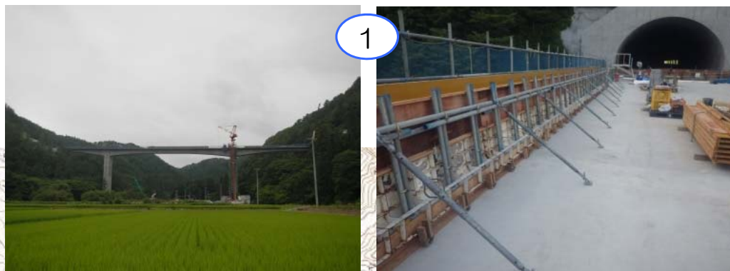
1 摂待大橋の桁（上部工）がつながりました。引き続き、防護柵（壁高欄）や伸縮装置などの橋梁附属物の施工を行ないます。
