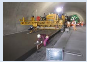
トンネル内の情報化施工※ 状況（コンクリート舗装）
