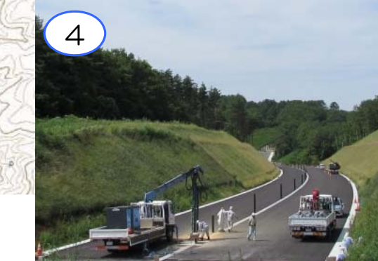
4 向新田地区では、ガードレールの支柱の設置を行なっています。
