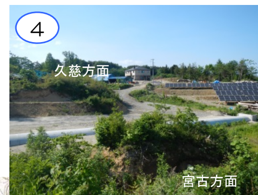
ナカヒラ沢と隣の沢が三沿道の本線の下へ埋まるので沢の水を通す横断管を設置する工事（2箇所）が完了しています。今後の工事で横断管の上を盛土して本線を構築する工事を行う予定です。
