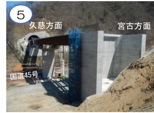
(仮称)新柳瀨橋の桁の架設が完了し、足場の解体を行なっています。
