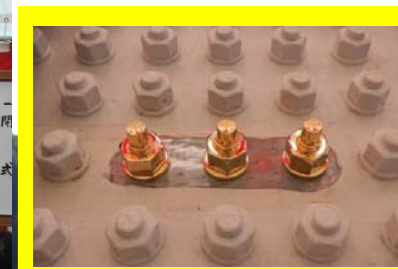
主桁最終ボルト
