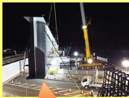
車を通る床を支える鉄の桁 をかけている
