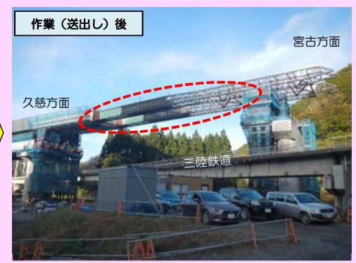
大きなジャッキで巨大な橋桁を押し出しています。
